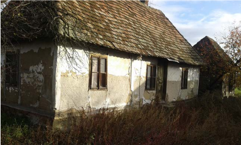
Слика 1. Примјер напуштеног објекта у Горњем Црњелову, 2018. (фотографија: Н. Закић)
